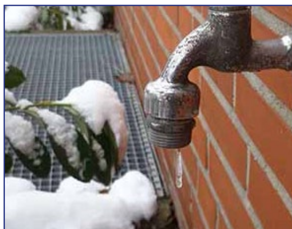
Außenwasserhähne und deren Zuleitungen müssen in der Frostperiode abgesperrt und entleert werden.
